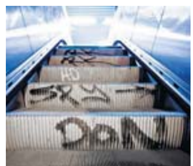
Am Wehrhahn sind beispielsweise Rolltreppen verunstaltet worden.
